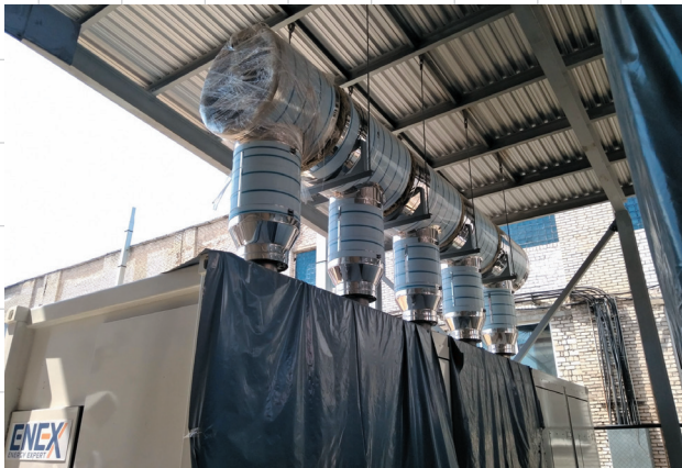
Монтаж готового изделия
